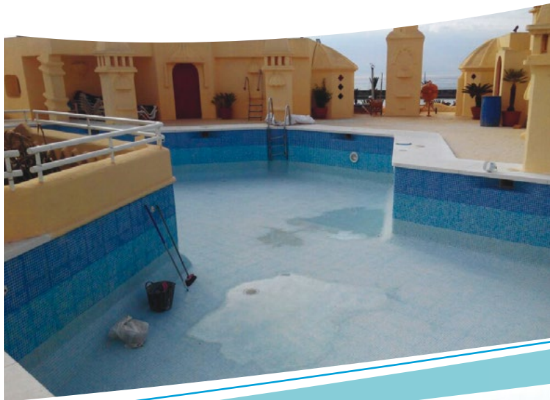
■ Colocación de nuevo gresite
