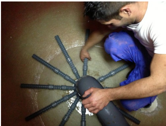
Sustitución de los colectores en un filtro
